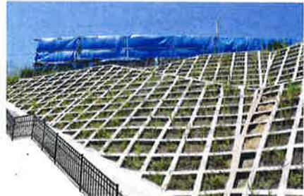
既に山を切り法面工事が終わっている部分。
