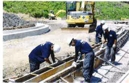
アクセス道の排水溝を整備しているところ。
